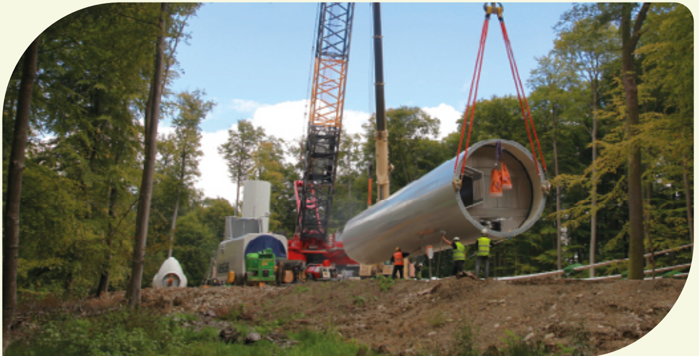
Montage des éoliennes pour un parc dans le Bas-Rhin.
