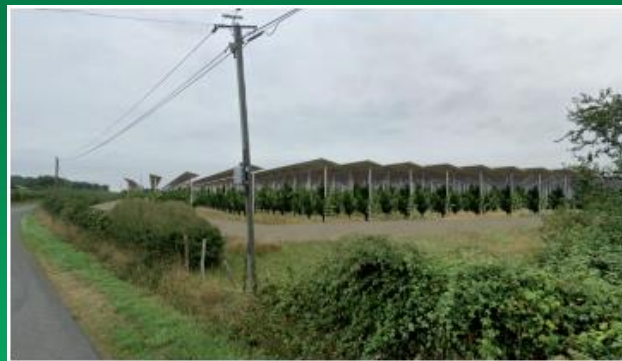
Vue 1 - Le projet sans mesure d'insertion paysagère Technique Solaire - 2024
