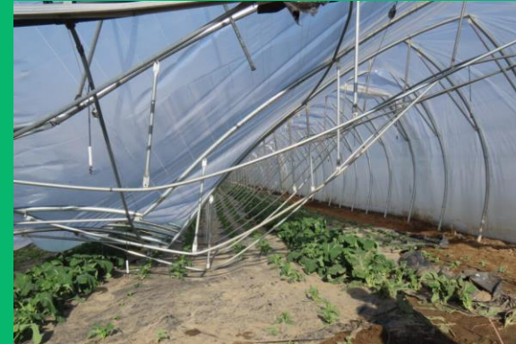
Dégâts constatés sur une serre tunnel après le passage de la tempête Ciaran en 2023
