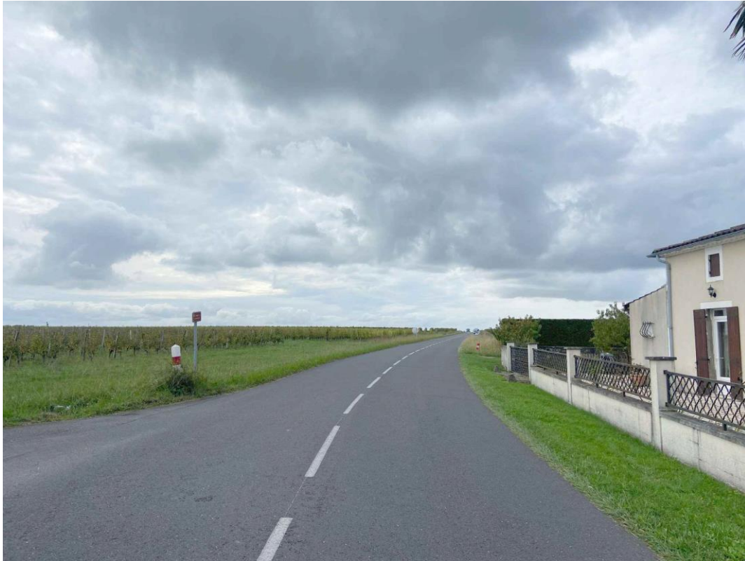
Vue 3 - état initial
