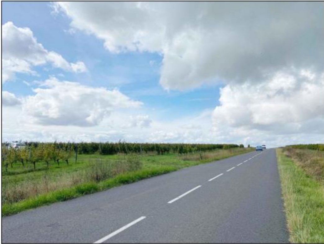
Vue 1 - état initial
